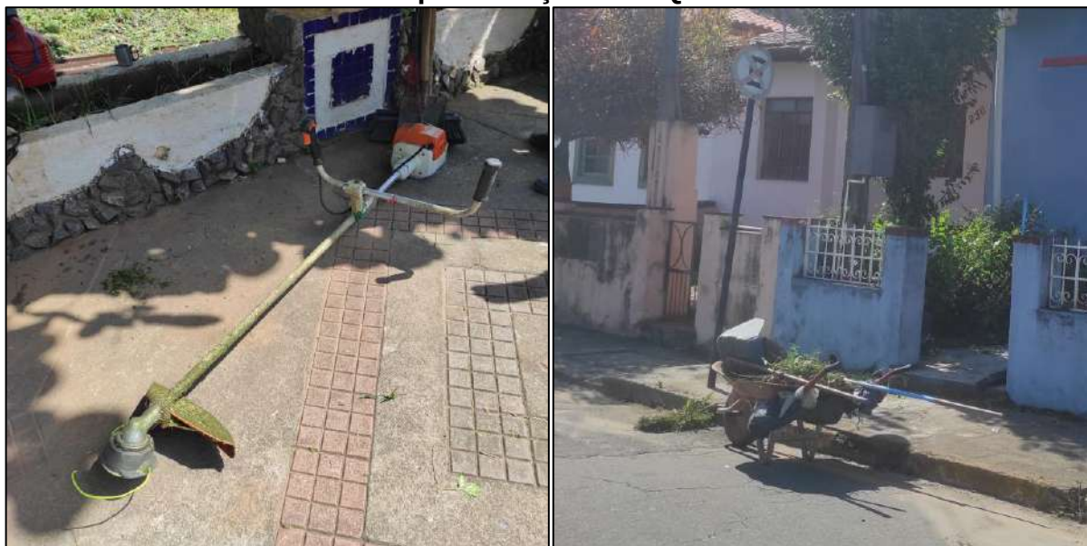
Figura 30 – Materiais e equipamentos utilizados para a execução dos serviços de capina e roçada em Queluz
