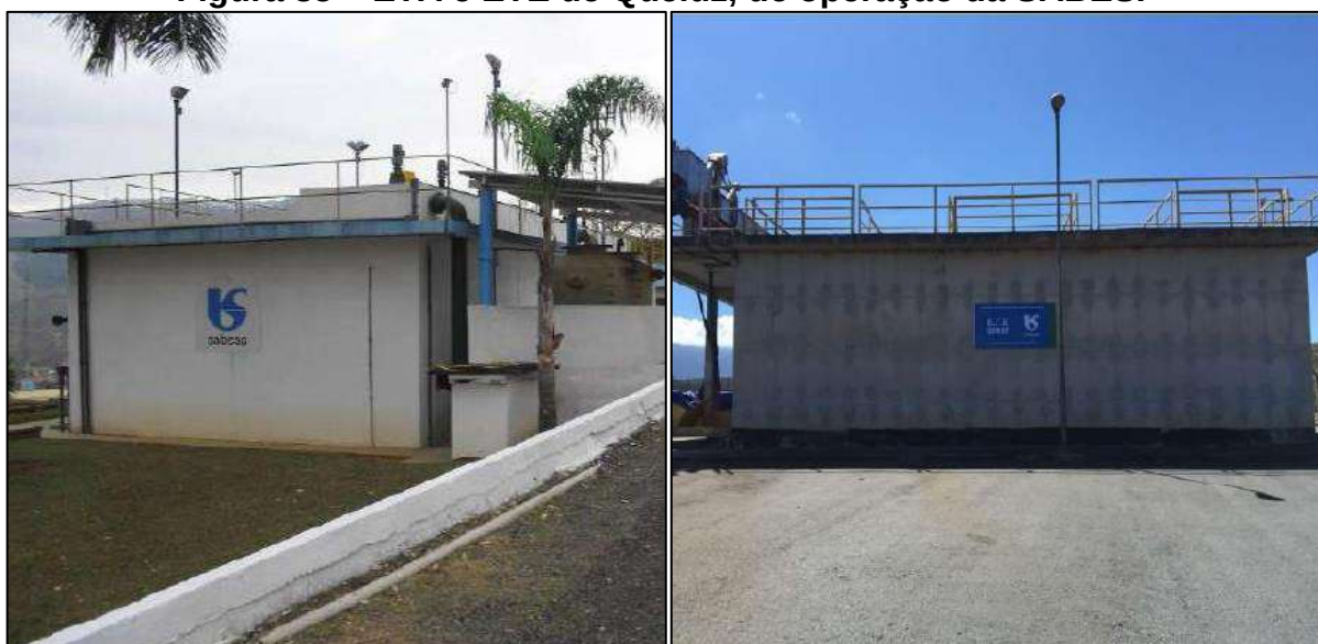
Figura 35 – ETA e ETE de Queluz, de operação da SABESP
