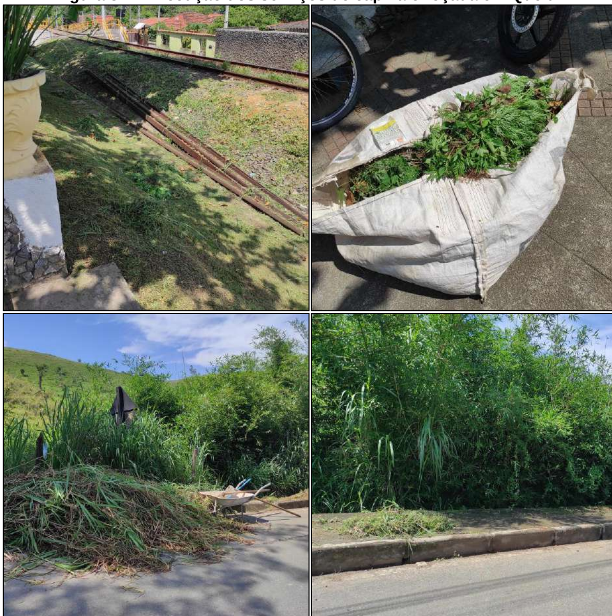
Figura 31 – Execução dos serviços de capina e roçada em Queluz
