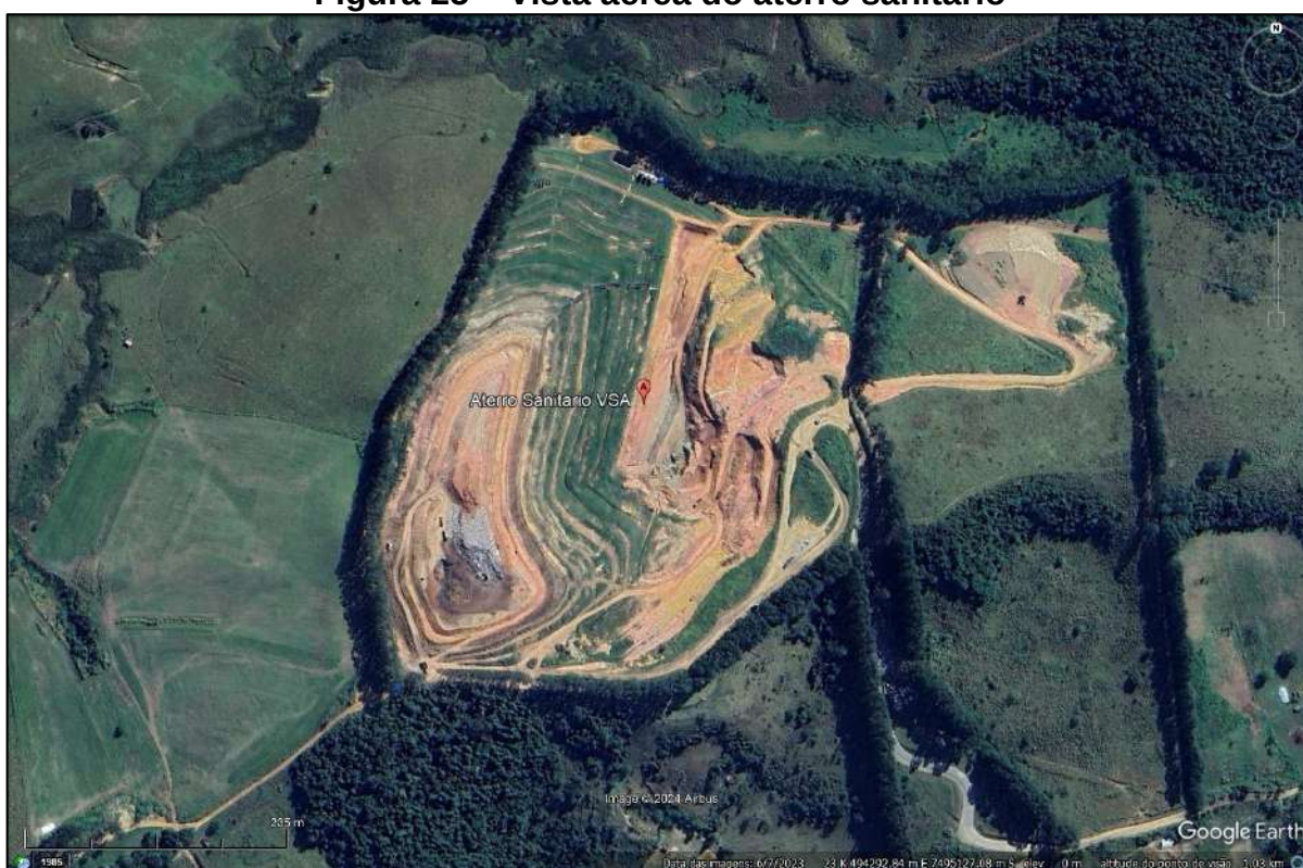
Figura 25 – Vista aérea do aterro sanitário
