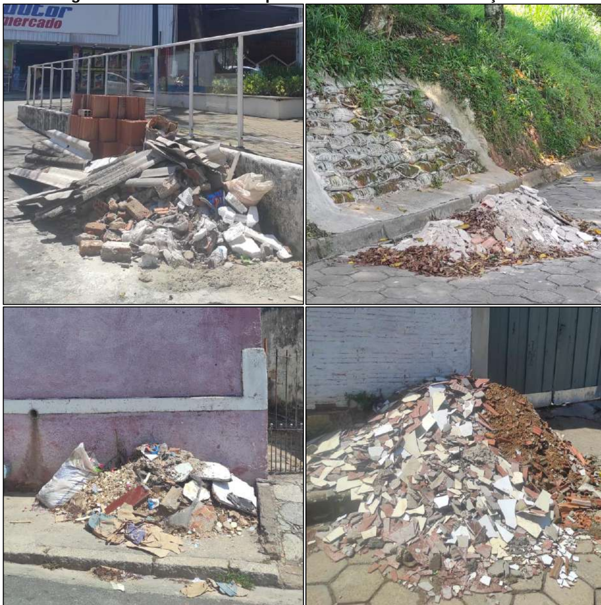
Figura 48 – Descarte inadequado de resíduos da construção civil
