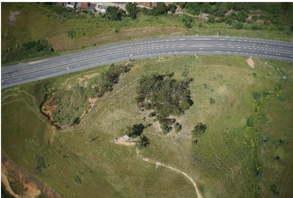
FIGURA 13 – VISTA AÉREA 07 FONTE: ACERVO DO AUTOR, 2022
