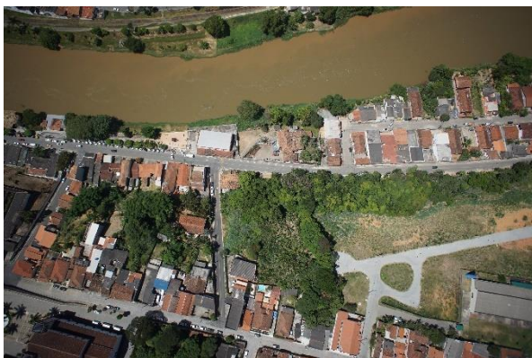
FIGURA 7 – VISTA AÉREA 01 FONTE: ACERVO DO AUTOR, 2022
