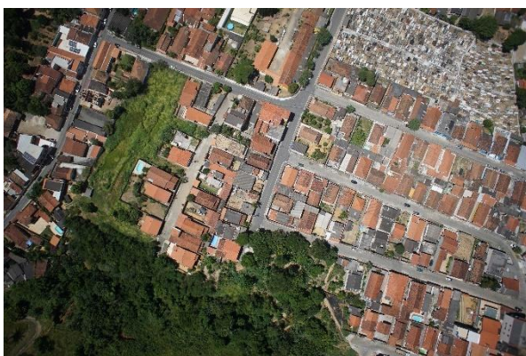
FIGURA 9 – VISTA AÉREA 03 FONTE: ACERVO DO AUTOR, 2022
