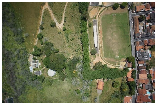
FIGURA 10 – VISTA AÉREA 04 FONTE: ACERVO DO AUTOR, 2022
