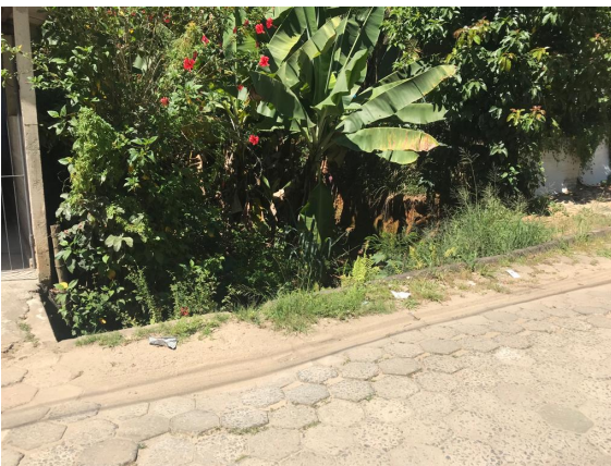
FIGURA 22 – PRESENÇA DE VEGETAÇÃO – VISTA 01 FONTE: ACERVO DO AUTOR, 2022
