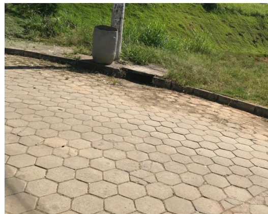
FIGURA 5 – REDE EXISTENTE / BOCA DE LOBO FONTE: ACERVO DO AUTOR, 2022
