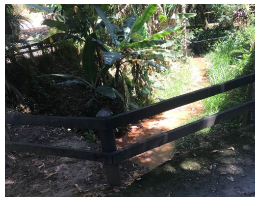
FIGURA 19 – GUARDA CORPO DE MADEIRA FONTE: ACERVO DO AUTOR, 2022
