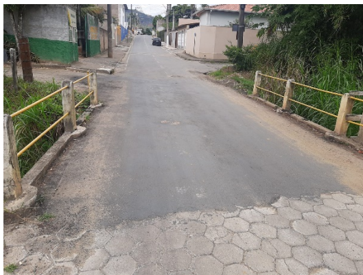
FIGURA 63 – PONTE NA ESTRADA MUNICIPAL HAMILCAR BEVILAQUA FONTE: ACERVO DO AUTOR, 2022
