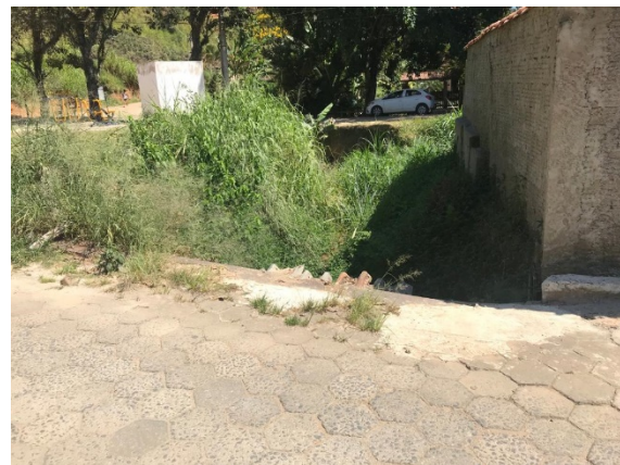
FIGURA 23 – PRESENÇA DE VEGETAÇÃO – VISTA 02 FONTE: ACERVO DO AUTOR, 2022
