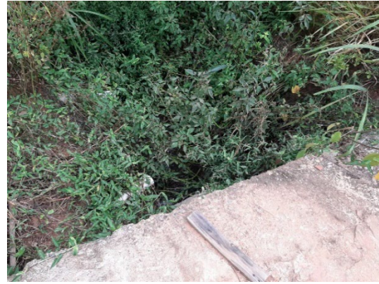
FIGURA 84 – TRAVESSIA EM TUBO DE CONCRETO – VISTA 2 FONTE: ACERVO DO AUTOR, 2022
