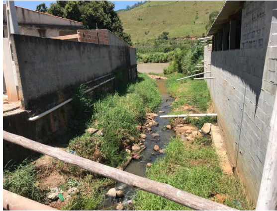
FIGURA 50 – PONTE SOBRE O RIO REGATA – LANÇAMENTO DE ESGOTAMENTO SANITÁRIO PRÓXIMO A FOZ FONTE: ACERVO DO AUTOR, 2022
