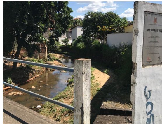
FIGURA 60 – PONTE SOBRE O RIO VERDE - VISTA A MONTANTE FONTE: ACERVO DO AUTOR, 2022
