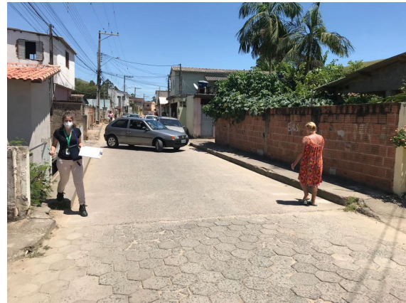
FIGURA 45 – TRAVESSIA COM PASSAGEM DO CURSO D'ÁGUA SOB RESIDÊNCIAS – VISTA 02 FONTE: ACERVO DO AUTOR, 2022
