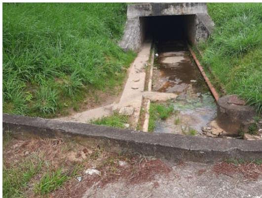
FIGURA 79 – TRAVESSIA NA RODOVIA PRESIDENTE DUTRA - VISTA 01 FONTE: ACERVO DO AUTOR, 2022
