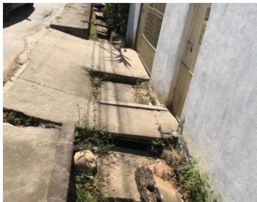
FIGURA 4 – REDE EXISTENTE / VALA DE DRENAGEM FONTE: ACERVO DO AUTOR, 2022
