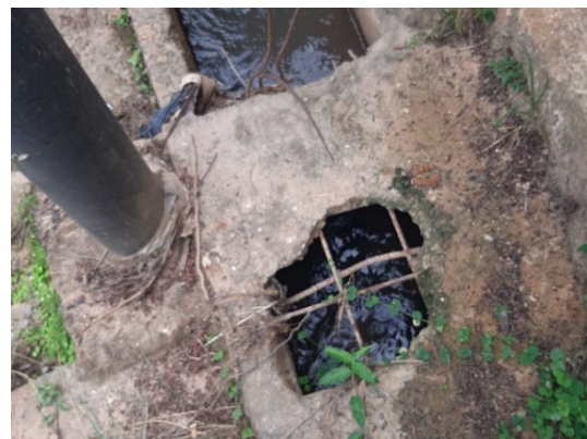
FIGURA 76 – REDUÇÃO/CONDUÇÃO DO CURSO D'ÁGUA PARA TUBO COM Ø30CM FONTE: ACERVO DO AUTOR, 2022
