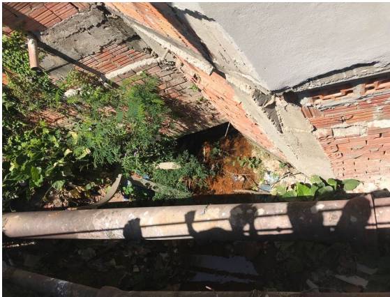
FIGURA 44 – ADUELA LOCALIZADA SOB RESIDÊNCIA A JUSANTE FONTE: ACERVO DO AUTOR, 2022
