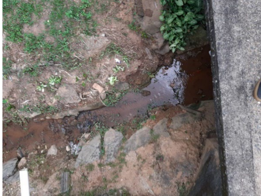
FIGURA 87 – PONTE EM LAJE DE CONCRETO FONTE: ACERVO DO AUTOR, 2022
