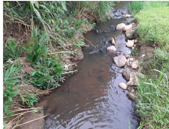
FIGURA 66 – TRAVESSIA SOBRE O RIO VERDE - VISTA A JUSANTE FONTE: ACERVO DO AUTOR, 2022
