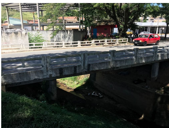
FIGURA 34 – PONTE SOBRE O RIO VERDE FONTE: ACERVO DO AUTOR, 2022
