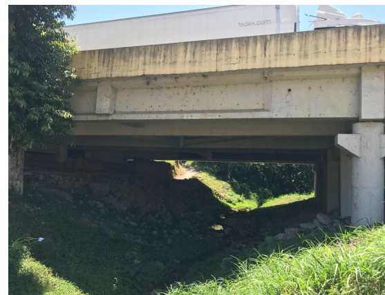
FIGURA 58 – PONTE NA RODOVIA PRESIDENTE DUTRA SOBRE O CÓRREGO DA PALHA – VISTA 02 FONTE: ACERVO DO AUTOR, 2022
