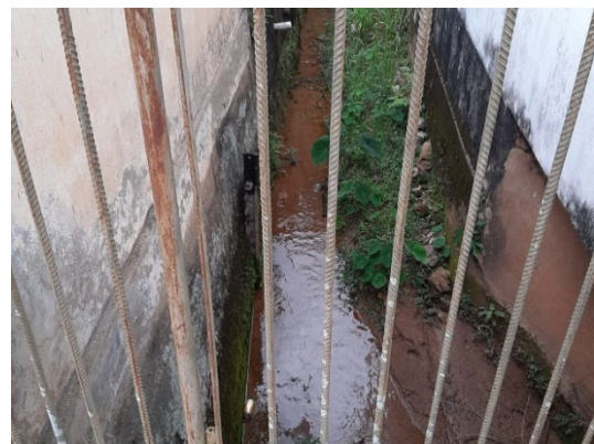
FIGURA 86 – TRAVESSIA PRÓXIMA AO SANTANDER – VISTA 2 FONTE: ACERVO DO AUTOR, 2022
