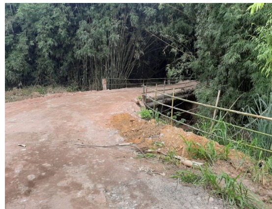
FIGURA 68 – PONTE SOBRE O RIO VERDE - VISTA A MONTANTE FONTE: ACERVO DO AUTOR, 2022
