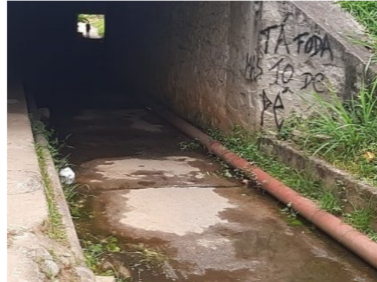
FIGURA 78 – TRAVESSIA LOCALIZADA NA RODOVIA PRESIDENTE DUTRA FONTE: ACERVO DO AUTOR, 2022
