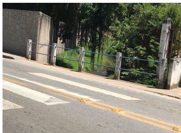
FIGURA 41 – CONDIÇÕES DA TRAVESSIA – VISTA 02 FONTE: ACERVO DO AUTOR, 2022
