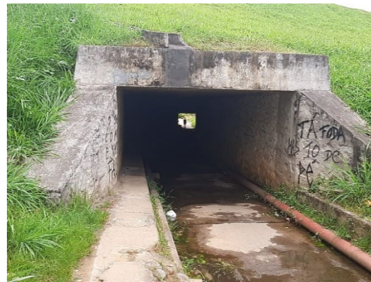
FIGURA 80 – TRAVESSIA NA RODOVIA PRESIDENTE DUTRA - VISTA 02 FONTE: ACERVO DO AUTOR, 2022
