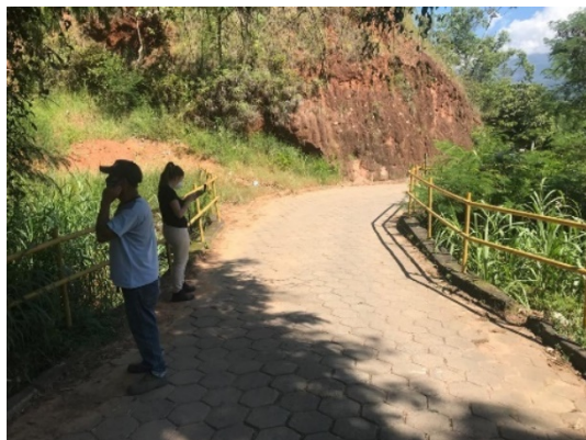
FIGURA 8 – TRAVESSIA EM CONJUNTO DE TUBO E ADUELAS FONTE: ACERVO DO AUTOR, 2022
