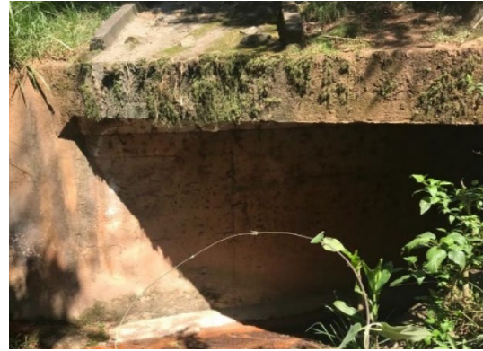
FIGURA 13 – TRAVESSIA COMPOSTA POR ADUELA DE CONCRETO FONTE: ACERVO DO AUTOR, 2022
