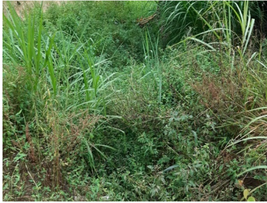
FIGURA 83 – TRAVESSIA EM TUBO DE CONCRETO – VISTA 1 FONTE: ACERVO DO AUTOR, 2022
