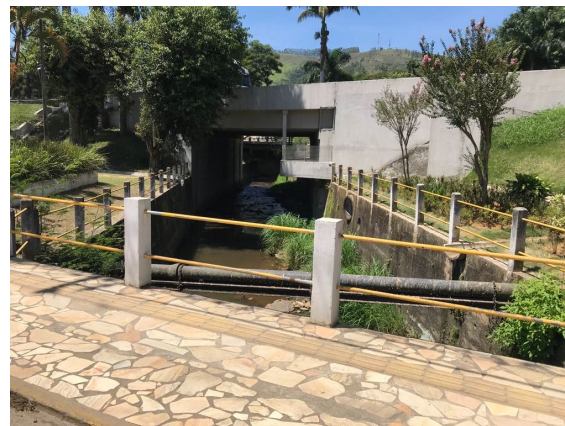
FIGURA 39 – VISTA A JUSANTE DA TRAVESSIA FONTE: ACERVO DO AUTOR, 2022
