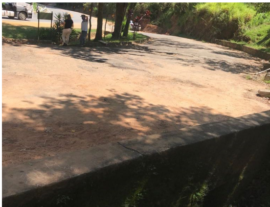
FIGURA 26 – TUBULAÇÃO SEGUI ENERRADA FONTE: ACERVO DO AUTOR, 2022
