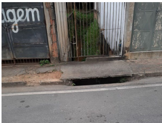
FIGURA 85 – TRAVESSIA PRÓXIMA AO SANTANDER – VISTA 1 FONTE: ACERVO DO AUTOR, 2022
