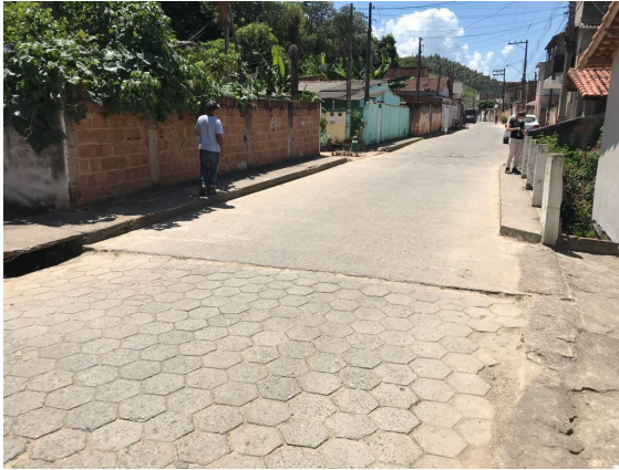
FIGURA 42 – TRAVESSIA COM PASSAGEM DO CURSO D'ÁGUA SOB RESIDÊNCIAS – VISTA 01 FONTE: ACERVO DO AUTOR, 2022
