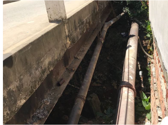
FIGURA 43 – CONDIÇÕES E CARACTERÍSTICAS DA TRAVESSIA FONTE: ACERVO DO AUTOR, 2022
