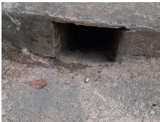
FIGURA 89 – BOCAS DE LOBO RECEBEM DRENAGEM DO SISTEMA VIÁRIO CONDUZINDO PARA O CANAL FONTE: ACERVO DO AUTOR, 2022
