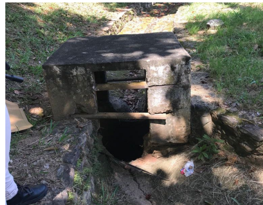
FIGURA 27 – ÁGUA É COLETADA POR TUBO DE QUEDA FONTE: ACERVO DO AUTOR, 2022
