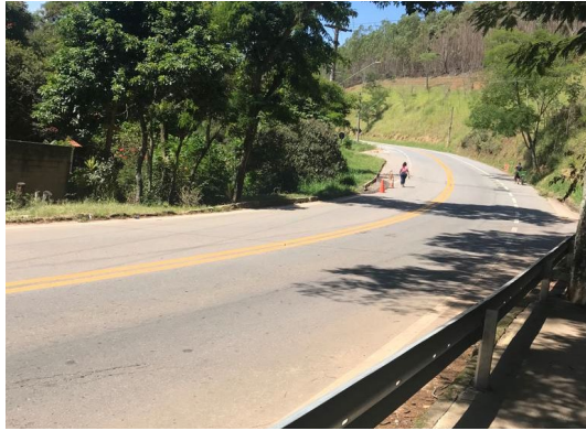
FIGURA 12 – RODOVIA QUELUZ - AREIAS FONTE: ACERVO DO AUTOR, 2022
