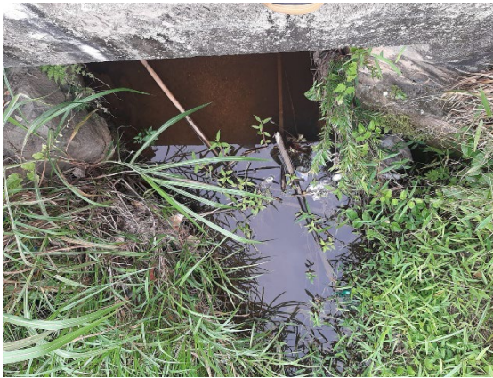
FIGURA 65 – PONTE SOBRE O RIO VERDE FONTE: ACERVO DO AUTOR, 2022
