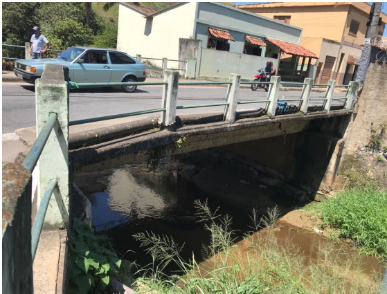
FIGURA 28 – PONTE SOBRE O RIO VERDE FONTE: ACERVO DO AUTOR, 2022
