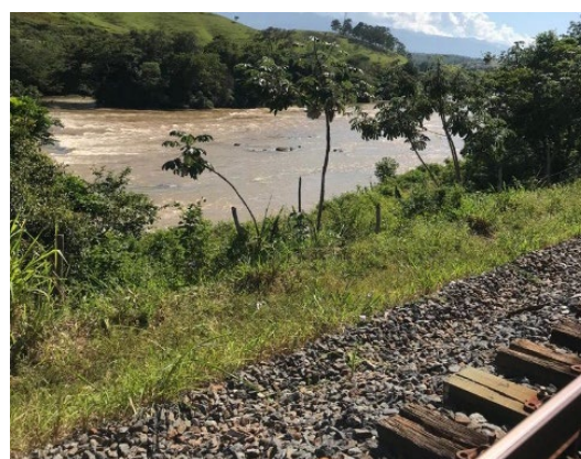
FIGURA 7 – LANÇAMENTO RIO PARAÍBA FONTE: ACERVO DO AUTOR, 2022
