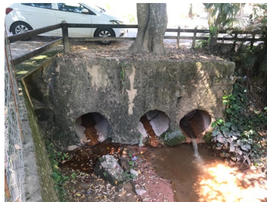
FIGURA 17 – TRAVESSIA EM TUBOS DE CONCRETO FONTE: ACERVO DO AUTOR, 2022
