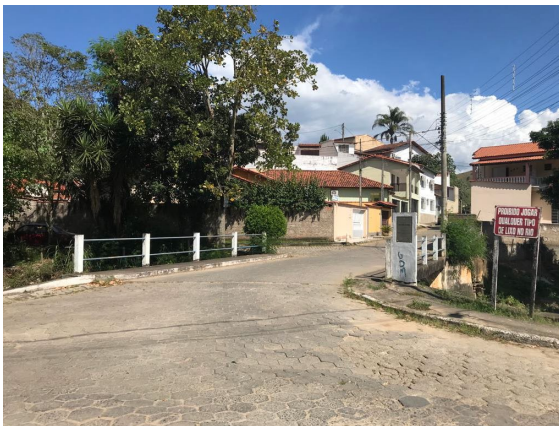
FIGURA 59 – PONTE SOBRE O RIO VERDE FONTE: ACERVO DO AUTOR, 2022
