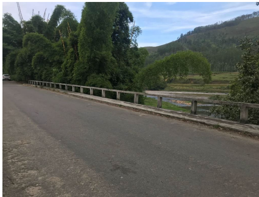
FIGURA 95 – PONTE SOBRE O RIO DAS CRUZES FONTE: ACERVO DO AUTOR, 2022
