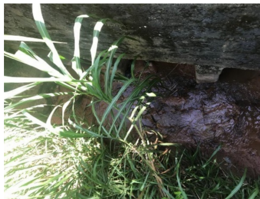
FIGURA 9 – TRAVESSIA EM CONJUNTO DE TUBO E ADUELAS FONTE: ACERVO DO AUTOR, 2022
