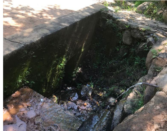
FIGURA 25 – ÁGUA DA GRUTA / ADUELA RECEPTORA FONTE: ACERVO DO AUTOR, 2022
