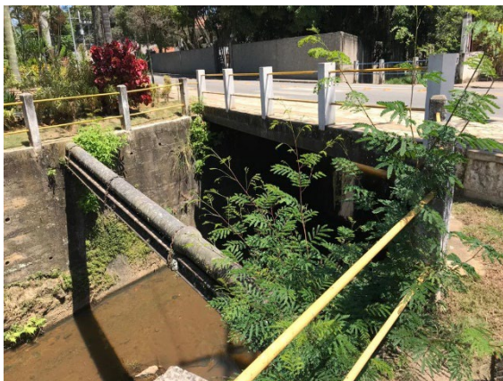
FIGURA 38 – PONTE SOBRE O RIO VERDE FONTE: ACERVO DO AUTOR, 2022
