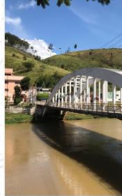
Ponte – 7,5 x 3,10m
