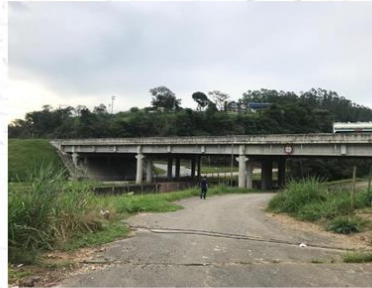
Ponte – 114,00 x 7,00m
