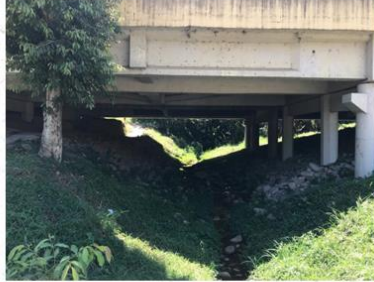
Ponte – 8,00 x 8,40m
