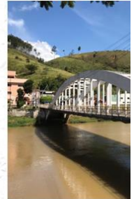
Ponte - 7,5 x 4,5m
