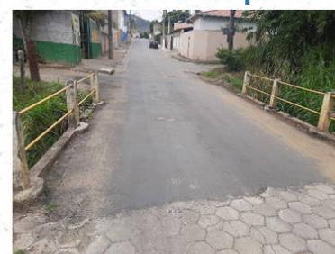
Ponte – 5,00 x 2,00m
