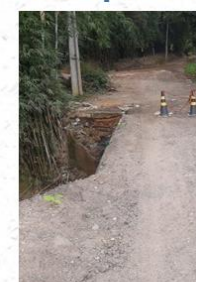
Ponte – 3,00 x 4,50m
