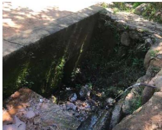
FIGURA 87 – ÁGUA DA GRUTA / ADUELA RECEPTORA FONTE: ACERVO DO AUTOR, 2022
