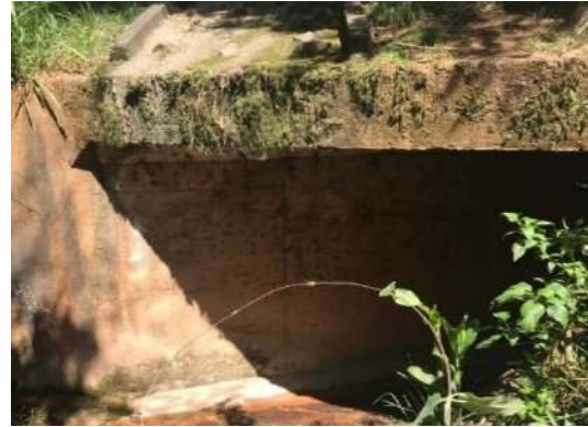
FIGURA 75 – TRAVESSIA COMPOSTA POR ADUELA DE CONCRETO FONTE: ACERVO DO AUTOR, 2022
