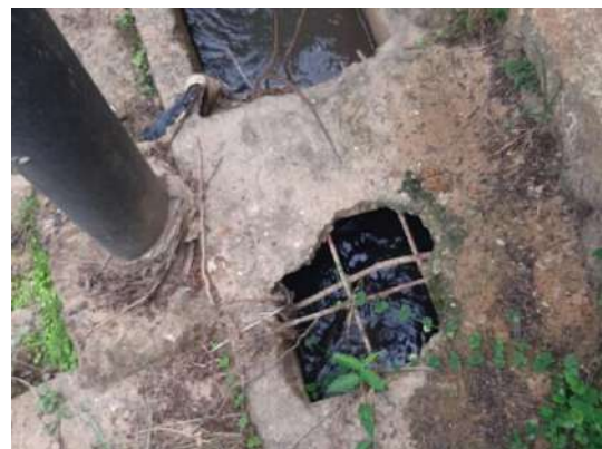
FIGURA 138 – REDUÇÃO/CONDUÇÃO DO CURSO D'ÁGUA PARA TUBO COM Ø30CM FONTE: ACERVO DO AUTOR, 2022
