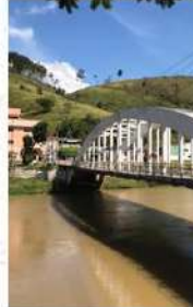
Ponte - 7,5 x 3,10m
