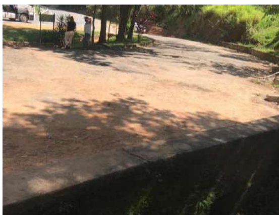
FIGURA 88 – TUBULAÇÃO SEGUI ENTEERRADA FONTE: ACERVO DO AUTOR, 2022
