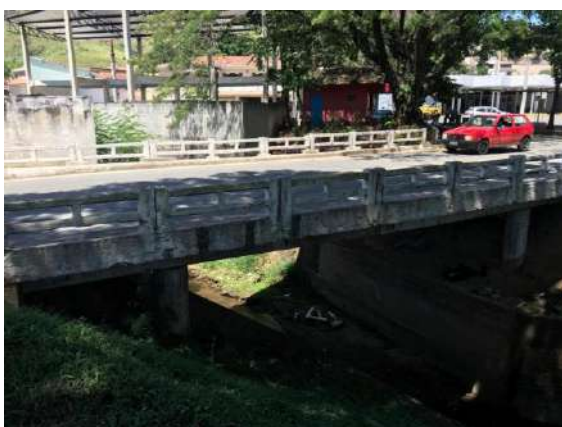
FIGURA 96 – PONTE SOBRE O RIO VERDE FONTE: ACERVO DO AUTOR, 2022
