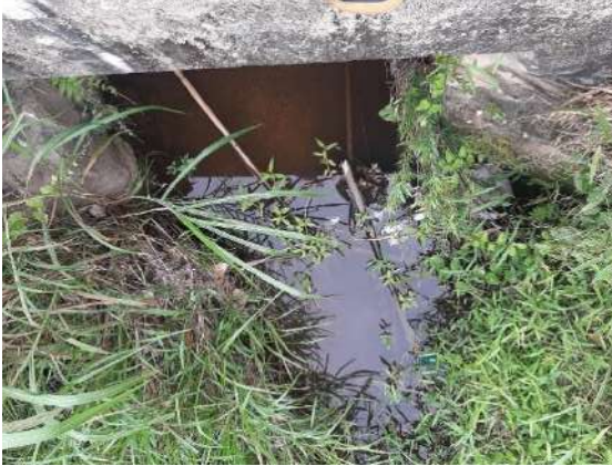
FIGURA 127 – PONTE SOBRE O RIO VERDE FONTE: ACERVO DO AUTOR, 2022
