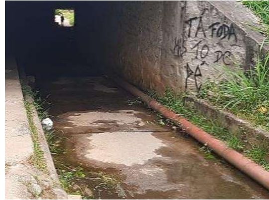
FIGURA 140 – TRAVESSIA LOCALIZADA NA RODOVIA PRESIDENTE DUTRA FONTE: ACERVO DO AUTOR, 2022
