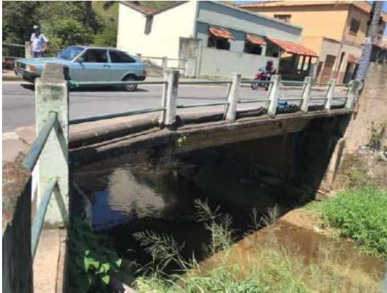
FIGURA 90 – PONTE SOBRE O RIO VERDE FONTE: ACERVO DO AUTOR, 2022
