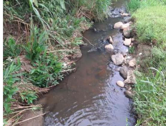
FIGURA 128 – TRAVESSIA SOBRE O RIO VERDE - VISTA A JUSANTE FONTE: ACERVO DO AUTOR, 2022
