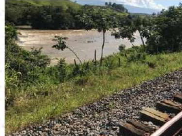
03 tubos - diâmetro de 0,60m
