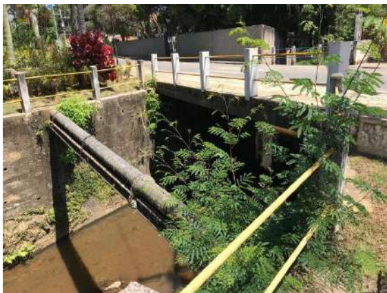
FIGURA 100 – PONTE SOBRE O RIO VERDE FONTE: ACERVO DO AUTOR, 2022
