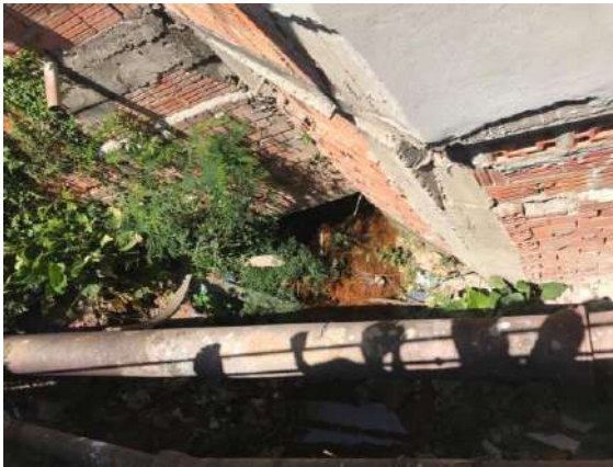
FIGURA 106 – ADUELA LOCALIZADA SOB RESIDÊNCIA A JUSANTE FONTE: ACERVO DO AUTOR, 2022
