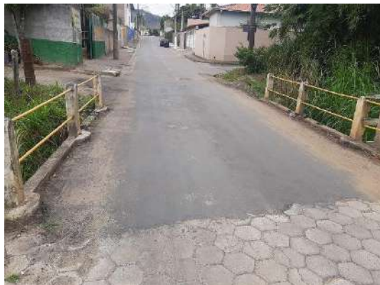
FIGURA 125 – PONTE NA ESTRADA MUNICIPAL HAMILCAR BEVILAQUA FONTE: ACERVO DO AUTOR, 2022
