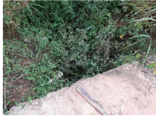
FIGURA 146 – TRAVESSIA EM TUBO DE CONCRETO – VISTA 2 FONTE: ACERVO DO AUTOR, 2022
