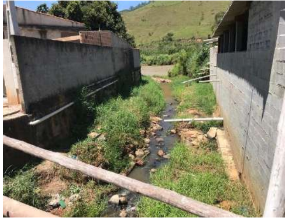
FIGURA 112 – PONTE SOBRE O RIO REGATA – LANÇAMENTO DE ESGOTAMENTO SANITÁRIO PRÓXIMO A FOZ FONTE: ACERVO DO AUTOR, 2022
