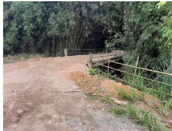
FIGURA 130 – PONTE SOBRE O RIO VERDE - VISTA A MONTANTE FONTE: ACERVO DO AUTOR, 2022
