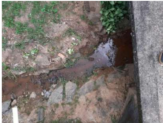
FIGURA 149 – PONTE EM LAJE DE CONCRETO FONTE: ACERVO DO AUTOR, 2022
