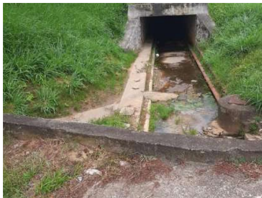
FIGURA 141 – TRAVESSIA NA RODOVIA PRESIDENTE DUTRA - VISTA 01 FONTE: ACERVO DO AUTOR, 2022
