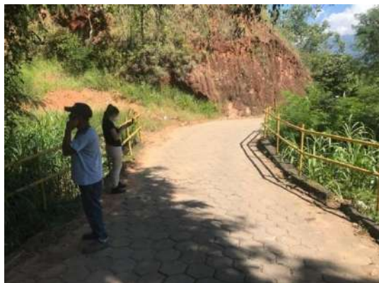
FIGURA 70 – TRAVESSIA EM CONJUNTO DE TUBO E ADUELAS FONTE: ACERVO DO AUTOR, 2022
