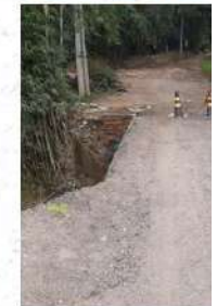
Ponte - 3,00 x 2,00m
