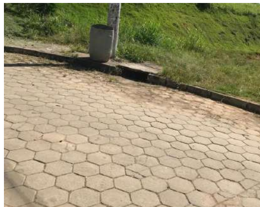
FIGURA 67 – REDE EXISTENTE / BOCA DE LOBO FONTE: ACERVO DO AUTOR, 2022
