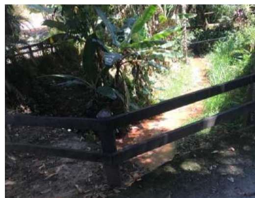
FIGURA 81 – GUARDA CORPO DE MADEIRA FONTE: ACERVO DO AUTOR, 2022
