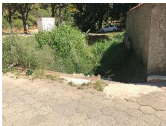
FIGURA 85 – PRESENÇA DE VEGETAÇÃO – VISTA 02 FONTE: ACERVO DO AUTOR, 2022
