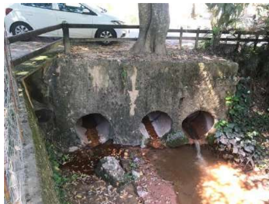
FIGURA 79 – TRAVESSIA EM TUBOS DE CONCRETO FONTE: ACERVO DO AUTOR, 2022
