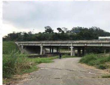
Ponte – 114,00 x 7,00m
