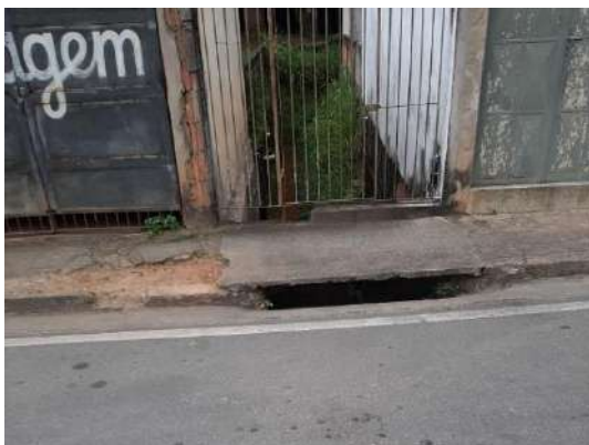
FIGURA 147 – TRAVESSIA PRÓXIMA AO SANTANDER – VISTA 1 FONTE: ACERVO DO AUTOR, 2022
