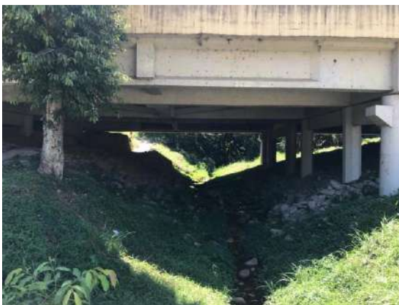
FIGURA 119 – PONTE NA RODOVIA PRESIDENTE DUTRA SOBRE O CÓRREGO DA PALHA – VISTA 01 FONTE: ACERVO DO AUTOR, 2022
