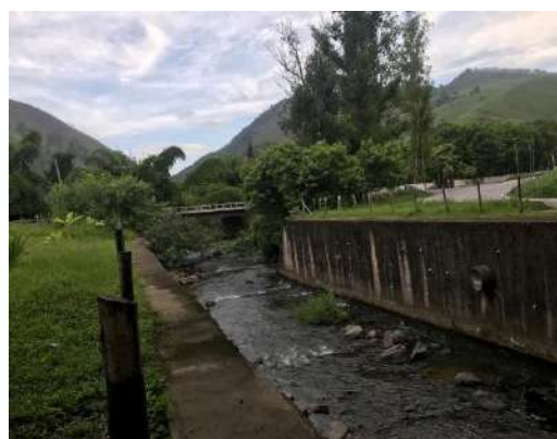
FIGURA 160 – CANAL ABERTO COM PAREDES DE CONCRETO ENTRE AS DUAS TRAVESSIAS – VISTA 02 FONTE: ACERVO DO AUTOR, 2022
