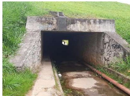
FIGURA 142 – TRAVESSIA NA RODOVIA PRESIDENTE DUTRA - VISTA 02 FONTE: ACERVO DO AUTOR, 2022
