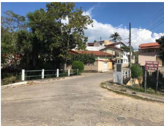
FIGURA 121 – PONTE SOBRE O RIO VERDE FONTE: ACERVO DO AUTOR, 2022
