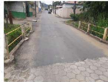
Ponte - 5,00 x 2,00m
