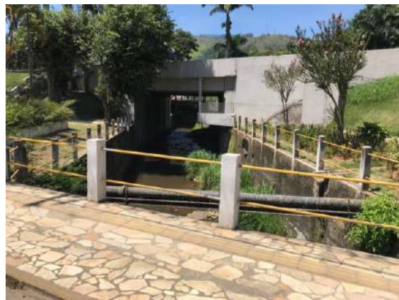
FIGURA 101 – VISTA A JUSANTE DA TRAVESSIA FONTE: ACERVO DO AUTOR, 2022
