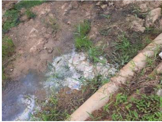
FIGURA 139 – TUBULAÇÃO REDUZIDA PARA TUBO COM Ø30CM FONTE: ACERVO DO AUTOR, 2022
