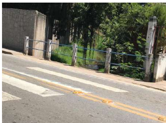
FIGURA 103 – CONDIÇÕES DA TRAVESSIA – VISTA 02 FONTE: ACERVO DO AUTOR, 2022
