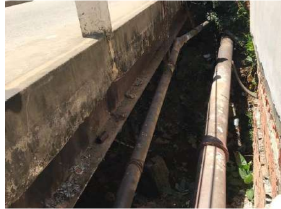
FIGURA 105 – CONDIÇÕES E CARACTERÍSTICAS DA TRAVESSIA FONTE: ACERVO DO AUTOR, 2022
