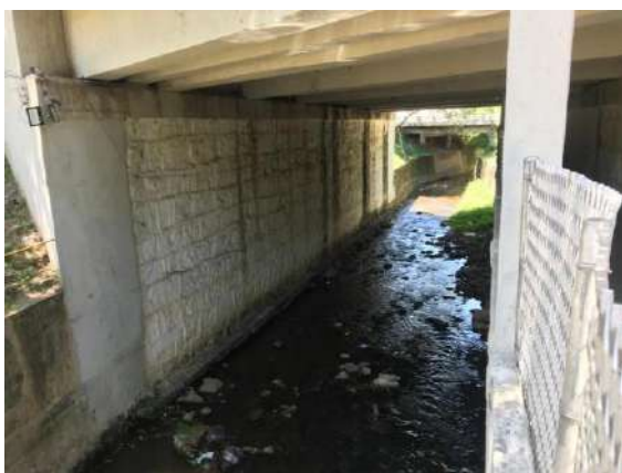
FIGURA 98 – PONTE NA RODOVIA PRESIDENTE DUTRA SOBRE O RIO VERDE FONTE: ACERVO DO AUTOR, 2022
