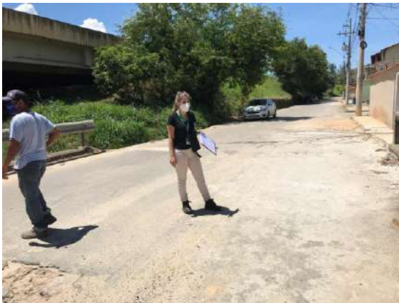
FIGURA 115 – PONTE SOBRE O CÓRREGO DA PALHA FONTE: ACERVO DO AUTOR, 2022
