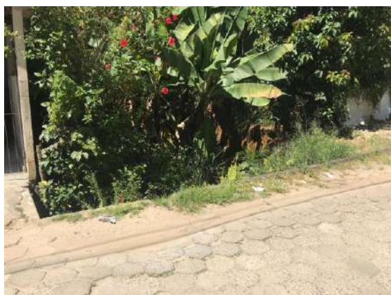
FIGURA 84 – PRESENÇA DE VEGETAÇÃO – VISTA 01 FONTE: ACERVO DO AUTOR, 2022
