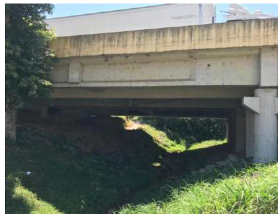
FIGURA 120 – PONTE NA RODOVIA PRESIDENTE DUTRA SOBRE O CÓRREGO DA PALHA – VISTA 02 FONTE: ACERVO DO AUTOR, 2022
