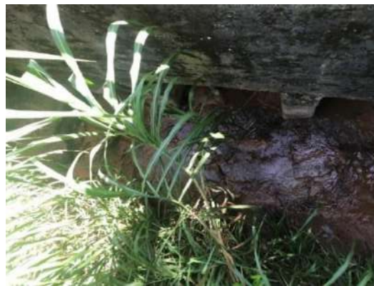
FIGURA 71 – TRAVESSIA EM CONJUNTO DE TUBO E ADUELAS FONTE: ACERVO DO AUTOR, 2022
