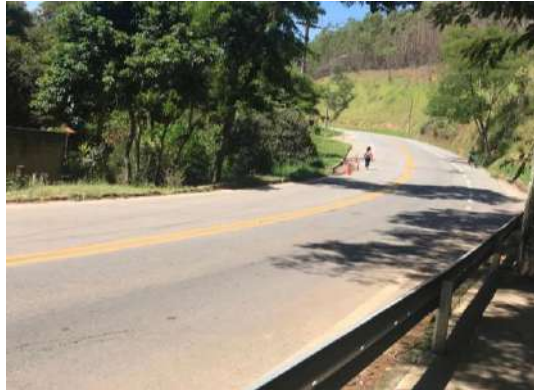
FIGURA 74 – RODOVIA QUELUZ - AREIAS FONTE: ACERVO DO AUTOR, 2022
