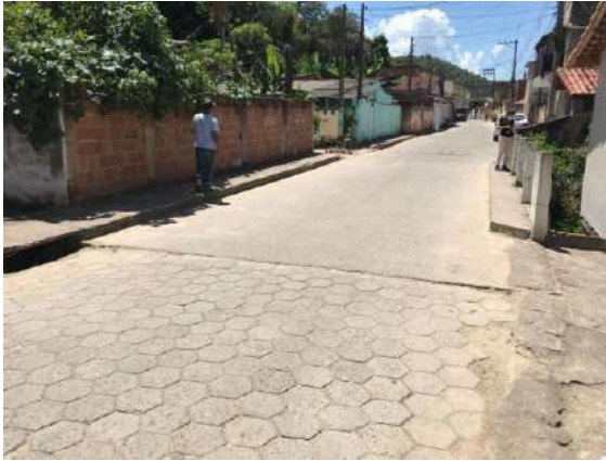
FIGURA 104 – TRAVESSIA COM PASSAGEM DO CURSO D'ÁGUA SOB RESIDÊNCIAS – VISTA 01 FONTE: ACERVO DO AUTOR, 2022
