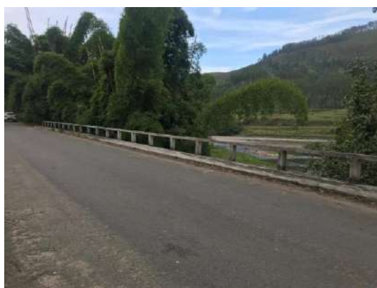
FIGURA 157 – PONTE SOBRE O RIO DAS CRUZES FONTE: ACERVO DO AUTOR, 2022
