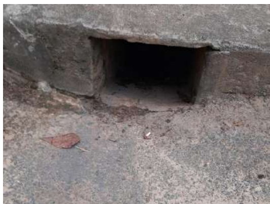
FIGURA 151 – BOCAS DE LOBO RECEBEM DRENAGEM DO SISTEMA VIÁRIO CONDUZINDO PARA O CANAL FONTE: ACERVO DO AUTOR, 2022
