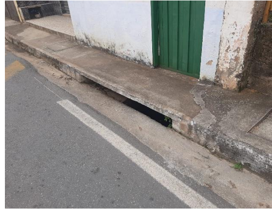
FIGURA 124 – BOCAS DE LOBO RECEBEM DRENAGEM DO SISTEMA VIÁRIO CONDUZINDO PARA O CANAL – VISTA 02 FONTE: ACERVO DO AUTOR, 2022
