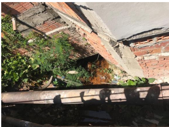
FIGURA 106 – ADUELA LOCALIZADA SOB RESIDÊNCIA A JUSANTE FONTE: ACERVO DO AUTOR, 2022
