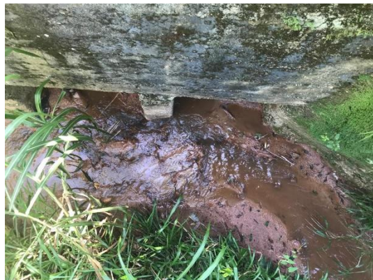
FIGURA 73 – SEÇÃO DA TRAVESSIA MUITO ASSOREADA FONTE: ACERVO DO AUTOR, 2022
