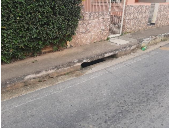
FIGURA 123 – BOCAS DE LOBO RECEBEM DRENAGEM DO SISTEMA VIÁRIO CONDUZINDO PARA O CANAL – VISTA 01 FONTE: ACERVO DO AUTOR, 2022
