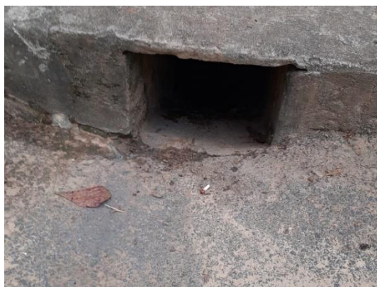
FIGURA 151 – BOCAS DE LOBO RECEBEM DRENAGEM DO SISTEMA VIÁRIO CONDUZINDO PARA O CANAL FONTE: ACERVO DO AUTOR, 2022
