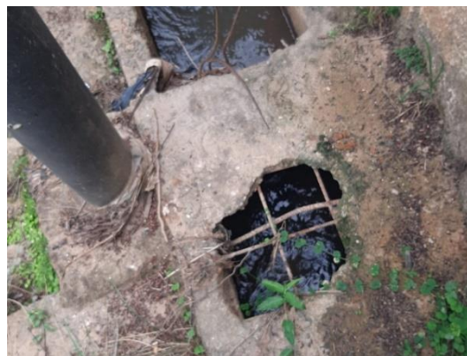
FIGURA 138 – REDUÇÃO/CONDUÇÃO DO CURSO D'ÁGUA PARA TUBO COM Ø30CM FONTE: ACERVO DO AUTOR, 2022
